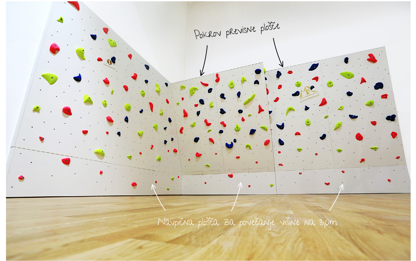
Šolska plezalna stena. Višina 3,0m, plezalna površina 30m 2 .
